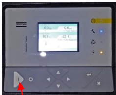
Trykk på startknappen når tørka mottar komprimert luft fra kompressor. Tørka er helautomatisk. Stopp knapp brukes når det ikke lenger går luft til tørka.
