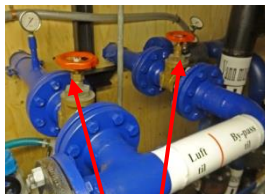
Rattet til venstre åpnes når en vil kjøre luft gjennom tørka. "By pass", til høyre brukes om linjene fylles før luften styres inn til tørka og når tørrstoffet skal regenereres.
