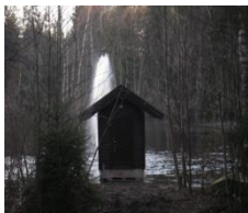
Pumpehus m/sirkulasjon og fontene i Kverndammen.
