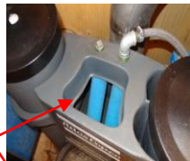
Fyll opp oljeseparator til det renne vann ut av markert ventil. Bruk grått skumgummifilter.
