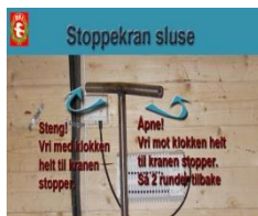
Åpne sluse til matepumpe.
